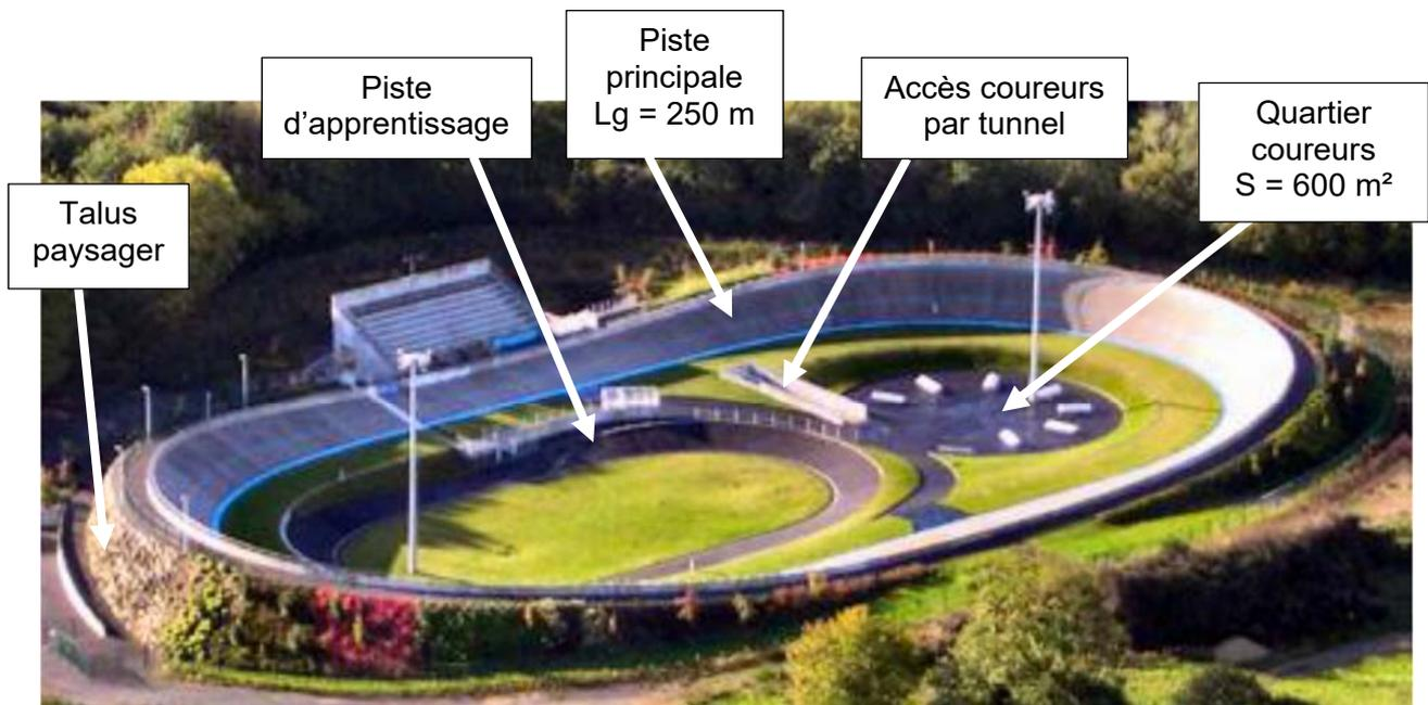
Dès le début du projet, le client envisageait une piste en béton, notamment pour sa capacité à résister aux intempéries. Il existe des pistes en béton sur remblai ou en béton sur ossature, dont les principes constructifs sont présentés dans le DT1.
